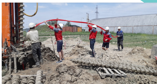
Сооружение грунтового теплового аккумулятора
