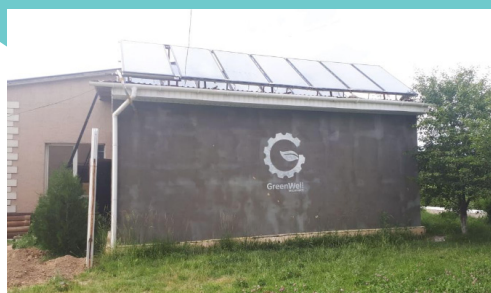
Система солнечных коллекторов для сбора солнечной тепловой энергии
